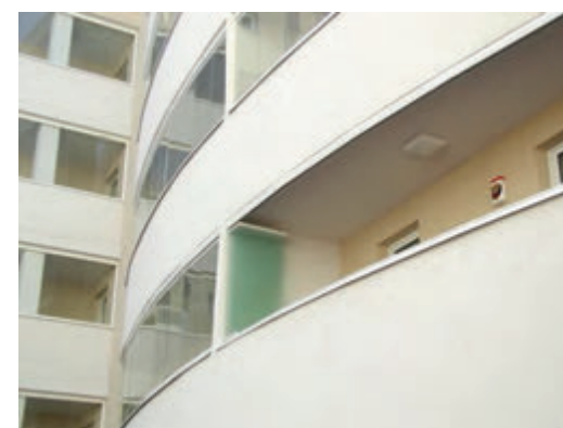
Referencia: Zasklenie lodžií bezrámovým otočným systémom.
